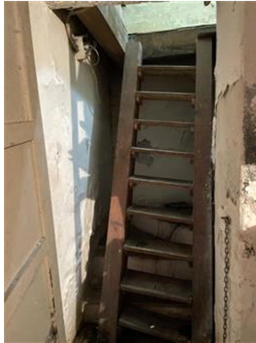
Botola e scala di accesso alla cantina.
